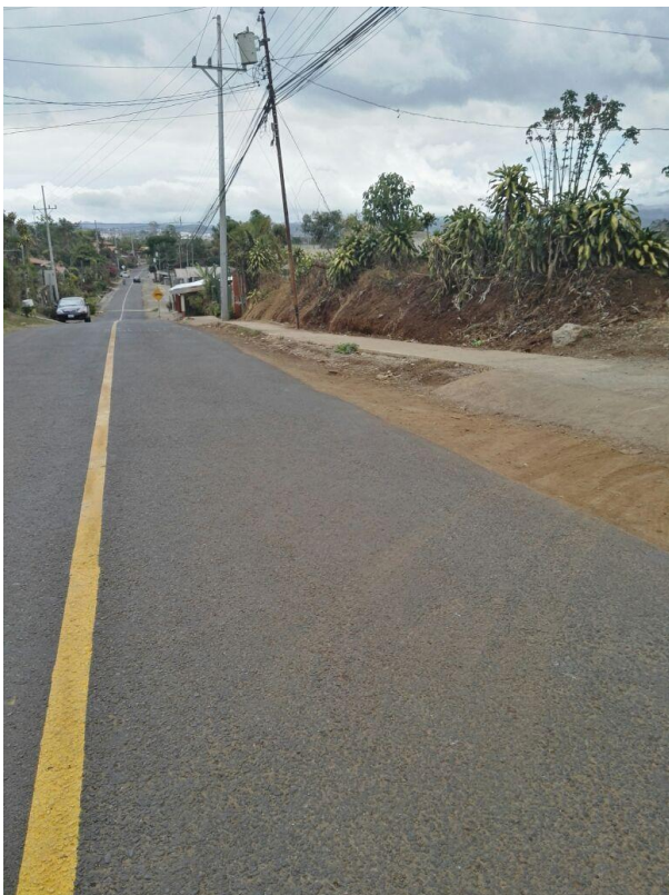
Aceras en construcción.
